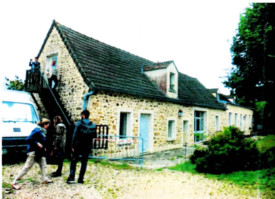
Vues de l'école sur cour - Etat actuel
